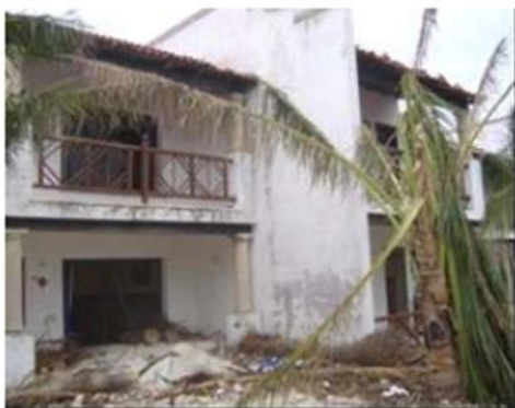
Foto 14 y 15 El inmueble se encuentra en Playa del Carmen ubicado en la primera línea de costa. Los daños causados en las instalaciones fueron debidos al oleaje y la marea, así como también por el viento generado por el huracán Wilma No hubo afectaciones a la estructura por tener fachadas abiertas
