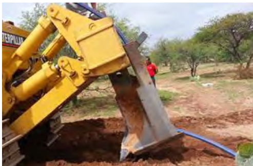
Ilustración 2. Preparación del ripper antes de instalación.
