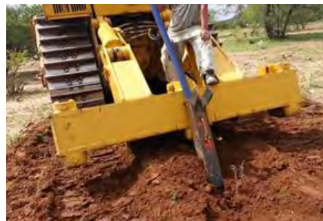
Ilustración 3. Instalación del ducto
