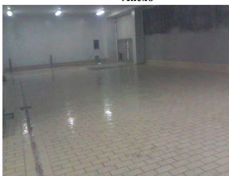
Fotografía 2 Instalación de Loseta en Giro Alimenticio.
