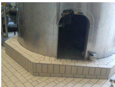
Fotografía 4 Instalación de Loseta en Base de Tanque
