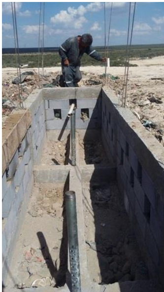
Imagen 5. Preparación para la base del quemador.
