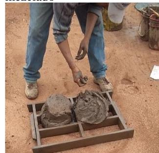
Ilustración 2. Vaciado de mezcla en adoberas
