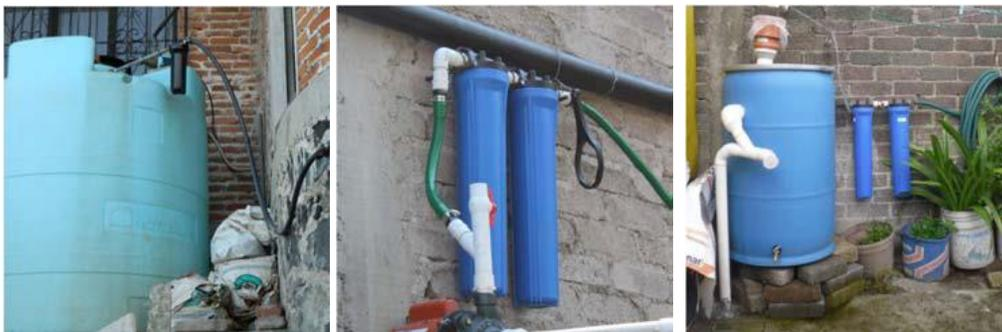
Figura 1,2 y 3 Sistema de captación de agua pluvial
