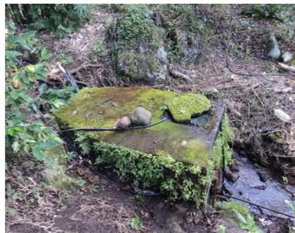
Figura 4. Tanque de regulación
