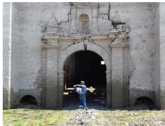
Imágenes 4 y 5. Daños estructurales en bóveda y fachada. Fotografías de autor
