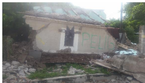
Figura 4- Edificación con muros de adobe
