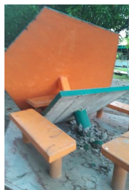
Figura 2- Flexión en columnas de concreto.
