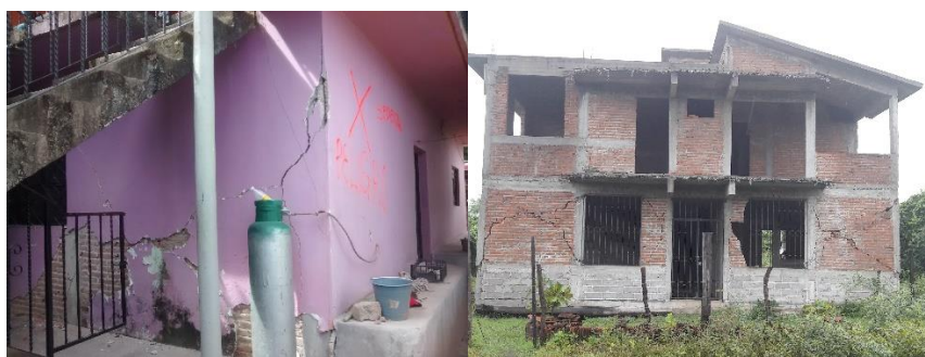
Figura 6- Cortante en muros
