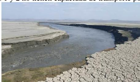
Figura 6. Evidencia del canal formado dentro del embalse, para un caudal de 40 m<sup>3</sup>/s a una cota de 90 m.
