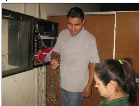
Figura 8. Desmontaje de aparatos de fibra óptica
