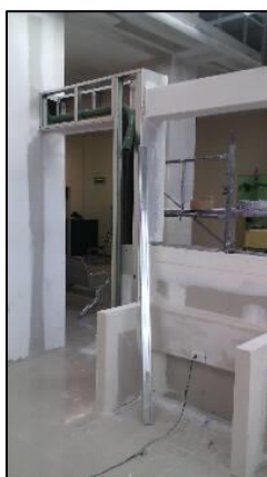
Figura 4. Estructura metálica para puertas y paso de tubería
