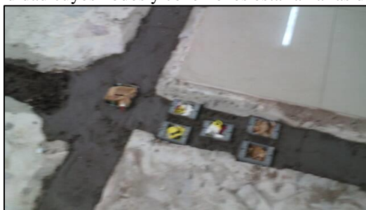
Figura 6. Zanja par cableado eléctrico y de datos
