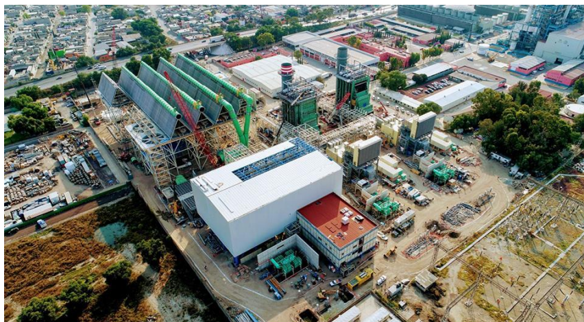
Figura 1. Planta termoeléctrica del Valle de México
