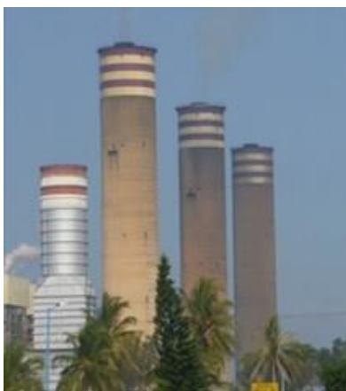
Figura 1. Chimenea de la Termoeléctrica de Tuxpan
