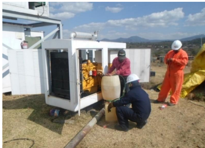
Figura 6. Generador habilitado para puesta en marcha de motor de bomba de recirculación.
