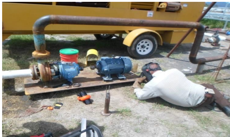
Figura 4. Instalación de tubería de salida y colocación de placa de acero como base para bomba y motor de recirculación.
