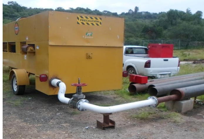
Figura 3. Instalación de tubería y válvula de compuerta a la entrada de la unidad de enfriamiento.
