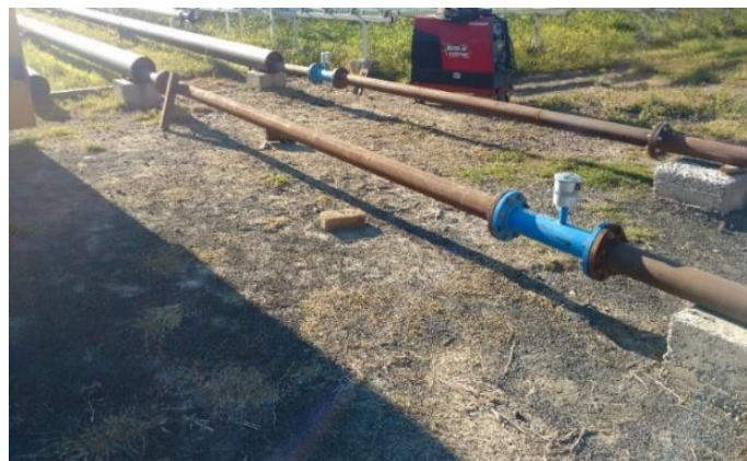
Figura 2. Tramo de tubería retirado para instalación de unidad de enfriamiento.
