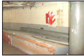
Figura 1.5 Colocación de extintores
