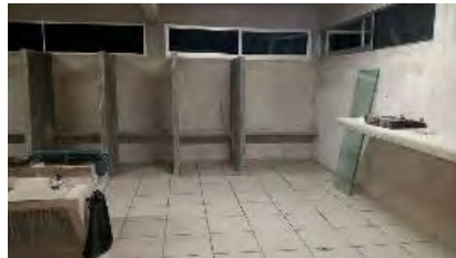
Figura 1.1 Zona de Baños antes de aplicar el programa de higiene y seguridad
