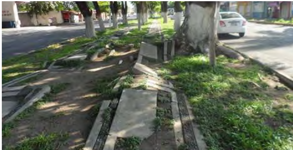
Figura 2: Camellón dañado por el crecimiento de las raíces de árboles. Av. Benito Juárez
