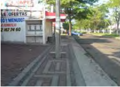
Figura No. 6: Obstrucción de banqueta Av. Benito Juárez
