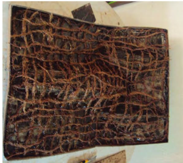
Figura 4. Armado final de la cubierta plegada
