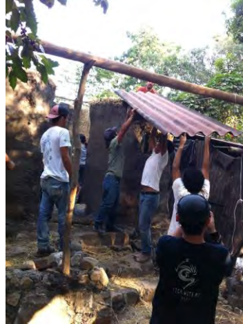
Imagen 9. Colocación de láminas.
