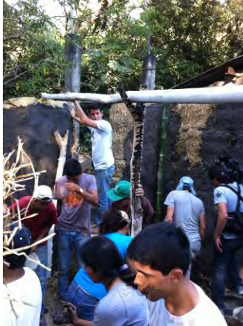
Imagen 8. Colocación de estructura bambú.
