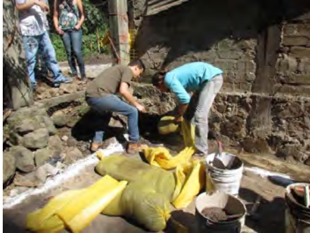
Imagen 5. Trazo de muros.
