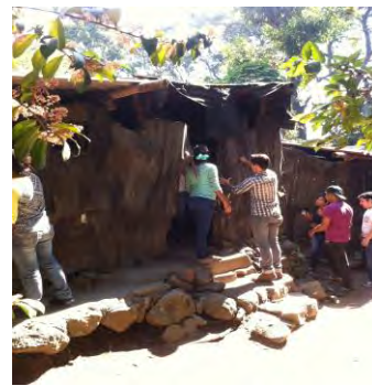
Imagen 4. Inicio de demolición de vivienda.
