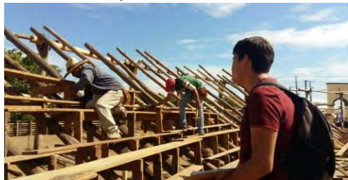
Figura 2. Observación durante el proceso de colocación de escuadras. Ortiz Llerenas I. M. (2016)
