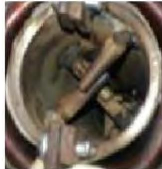
Figura 11. Disipadores (aletas) soldados en el interior del tubo.
