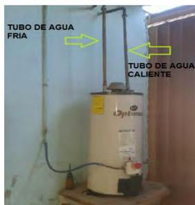
Figura 4. Instalación de un calentador para una casa y las especificaciones de los tubos de agua caliente y fría.
