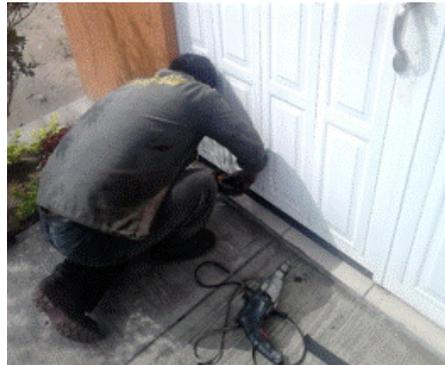
Figura 8. Colocación de guardapolvo y tapetes.
