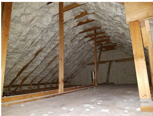
Figura 4.- Aplicación de SFP en techo (Imagen obtenida en trabajo de campo)
