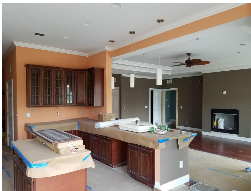
Figura 7.- Proceso de pintura y detalle (Imagen obtenida en trabajo de campo)
