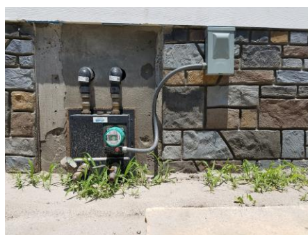
Figura 2.- Bomba de Calor (Imagen obtenida en trabajo de campo)
