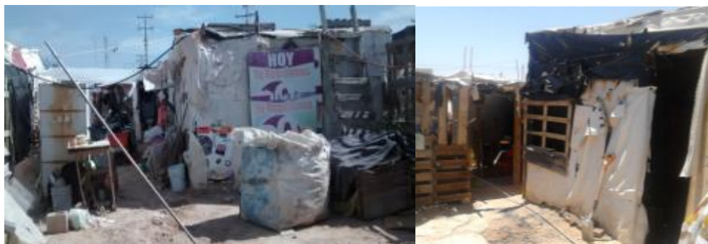
Fotos 3, 4. Viviendas construidas en base a desechos urbanos, colonia Zaragoza sur.
