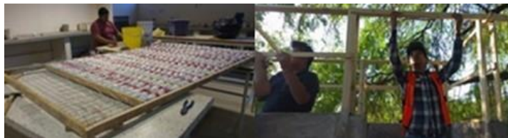
Figura 10. Techumbre base pets y acabados.
