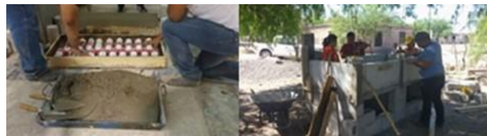
Figura 9. Construcción e instalación de block muro base pets.
