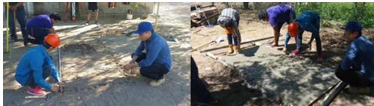
Figura 7. Localización Trazo y despálme del terreno y Losa de cimentación.
