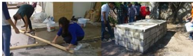
Figura 8. Celdas de captación
