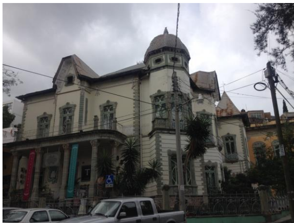
Figura 1. Fachada principal de la casa. 2018.
