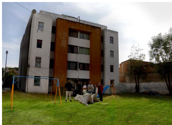
Figura 4 Estado final del área intervenida / Autores del proyecto
