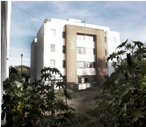
Figura 5 Estado inicial del área verde a recuperar / Autores del proyecto
