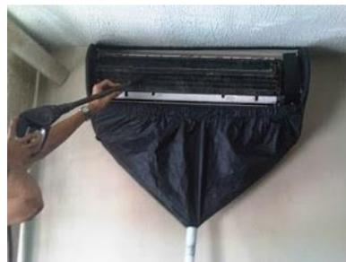
Figura 4. Forro para captar agua en el mantenimiento.
