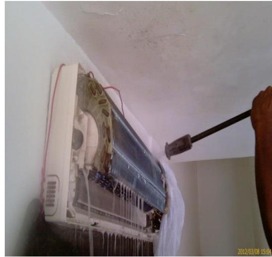
Figura 2. Lavado del equipo de aire acondicionado Split
