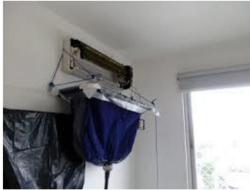
Figura 5. Forro con salida de agua y sujetadores
