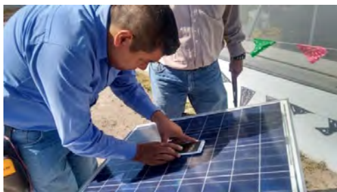
Figura 8 Inclinación mediante PV Solar Power
