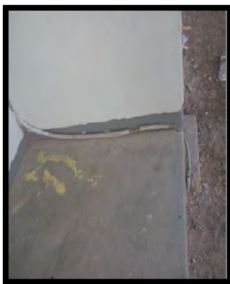
Figura 1. Deficiencias en instalación eléctrica
