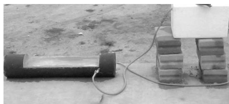
Figura 4. Instalación y pruebas de Funcionamiento del Colector solar Tubular.
