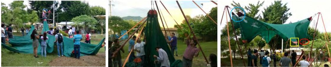
**Figura. 22, 23, 24.** Observamos el proceso del primer montaje, el cual tuvo fallas por la mala unión concurrente de los puños metálicos al anclaje de los postes y ocasiono que la velarías estuviese arrugada en algunas partes. Fuente: Morales (2014).
