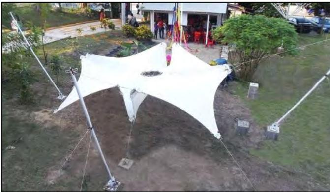
**Figura. 18.** Observamos la velaría ya tensada y colocada con sus postes metálicos articulados, ayudan a dar la flexibilidad a las estructuras tensadas. Fuente: Morales (2013).
