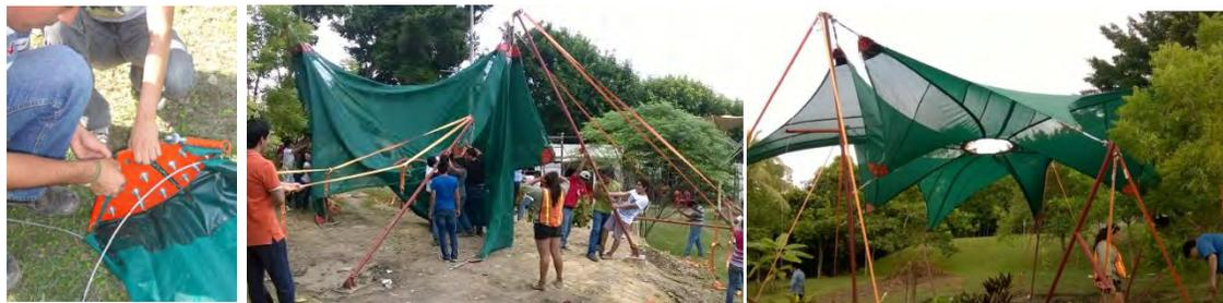
**Figura. 25, 26, 27.** Observamos el segundo proceso de montaje, el cual se corrigió las desviaciones de los puños metálicos, por lo que en el segundo izaje tensó toda la velaría y no se formaron arrugas que pudieran dañar la estructura. Fuente: Morales (2014).
