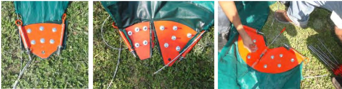
**Figura. 19, 20, 21.** Observamos que las uniones están reforzadas con una membrana de lona, este ayudara a absorber la tensión que puede ocasionar las uniones metálicas en la membrana. Fuente: Morales (2014).
