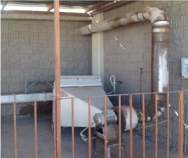
Figura 5. Sistema de calentamiento del horno.
