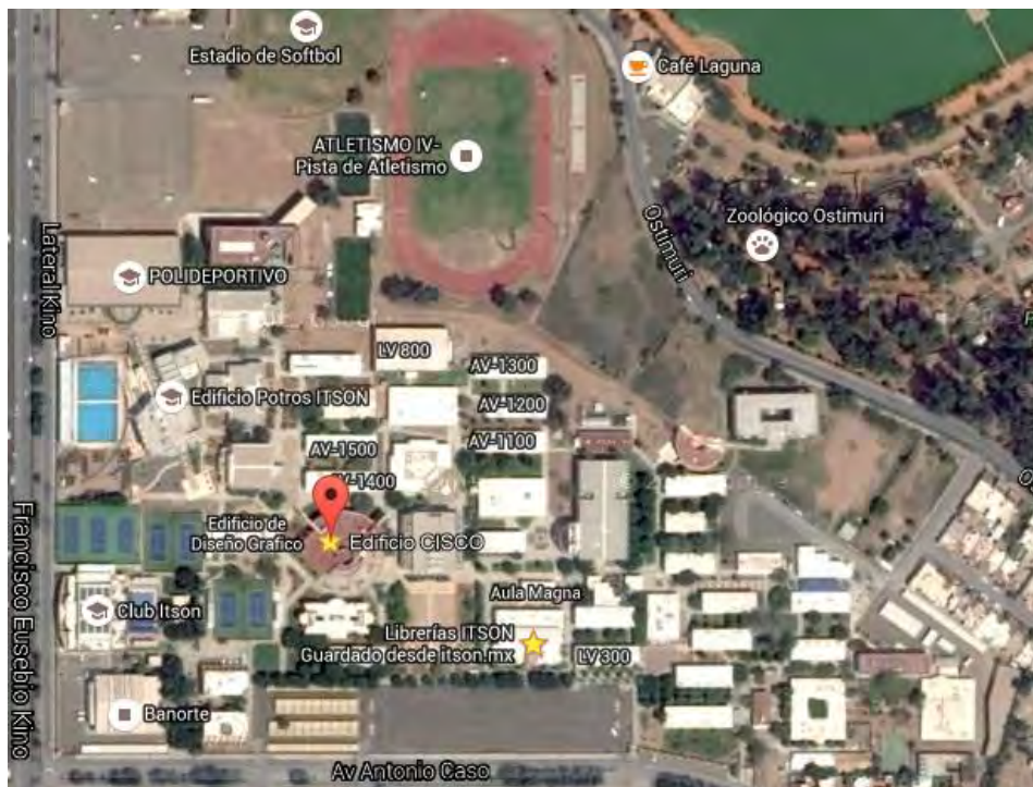
Figura 1. Vista aérea del edificio CISCO
