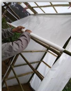
Figura 2. Construcción del Módulo protegido para el secado de café.
