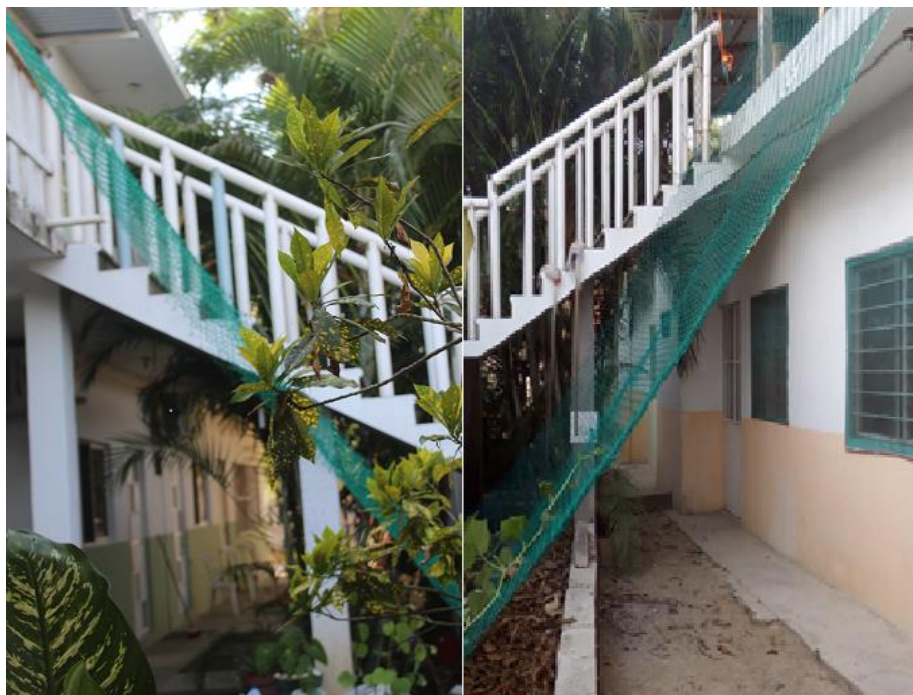
Figura 2. Malla ciclónica PVC instalada, imagen ala izquierda lado de prueba, y lado derecho área de referencia
