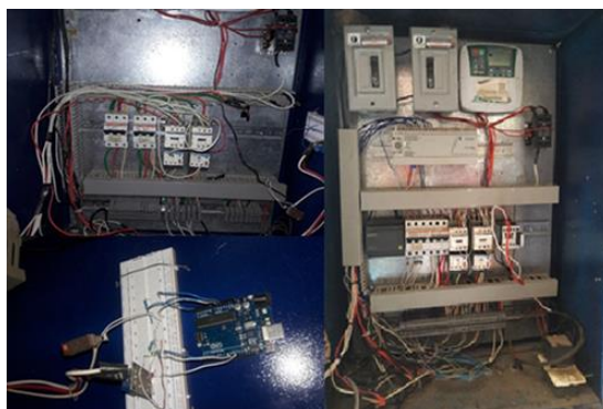
Figura 3. Tablero inicialmente y tablero terminado
