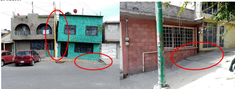
Figura 3. Daños en las viviendas de la U.H. Ermita Zaragoza. Izq. Pérdida de verticalidad y horizontalidad de la vivienda. Der. Niveles diferenciales de viviendas contiguas a partir de nivel de banquetta. Fotos: Baca, 2020.
