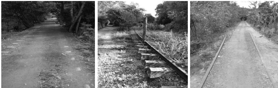
Imagen 1, Vía férrea actual Dindal-Caparrapí Cundinamarca
