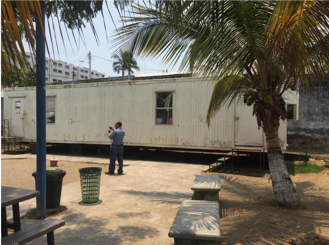
Figura 3. Aulas móviles, instaladas de manera “temporal, desde el 2009
