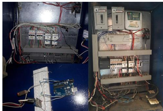
Figura 3. Tablero inicialmente y tablero terminado
