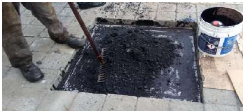
Figura 2. Inclusión de geomalla de fibra de vidrio en carpeta
