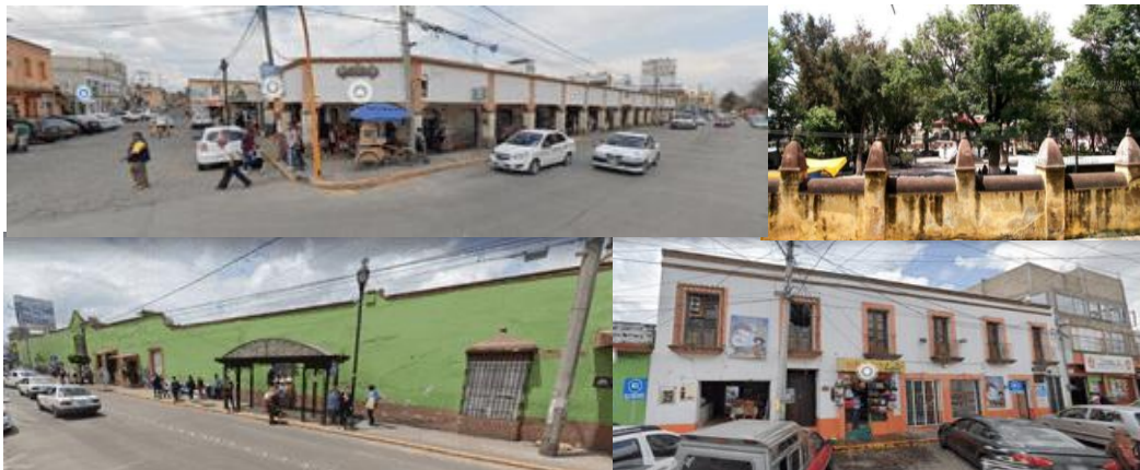
Figura 2.3. Deterioro del Centro Histórico y edificios catalogados como patrimonio cultural.
