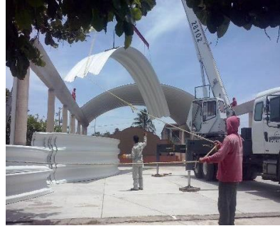
Figura 1. Montaje de cubierta autoportante.
