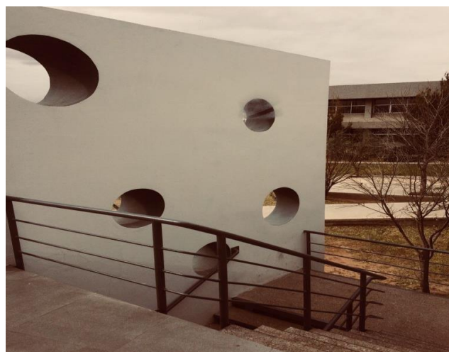
Figura 2 Escaleras Exteriores del Edificio O
