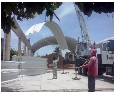
Figura 1. Montaje de cubierta autoportante.
