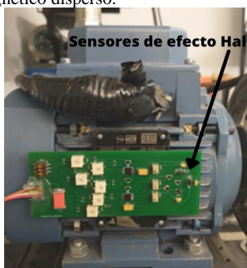
Figura 3. Instalación del Sensor Triaxial de flujo propietario.
