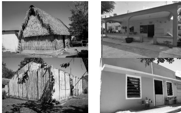
Figura 7 Comparación de las viviendas vernáculas y las viviendas actuales.
