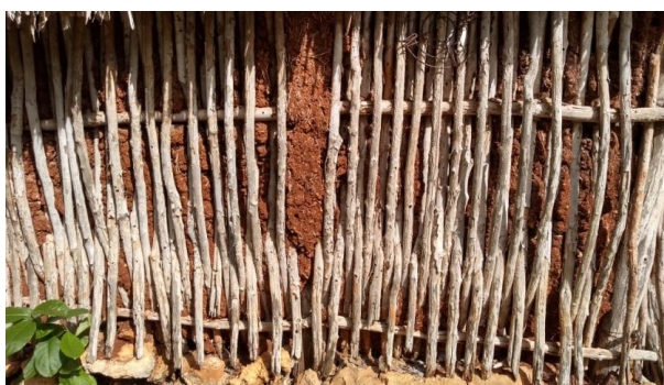
Ilustración 5. Detalle de tejido de muro (Colox-ché)
