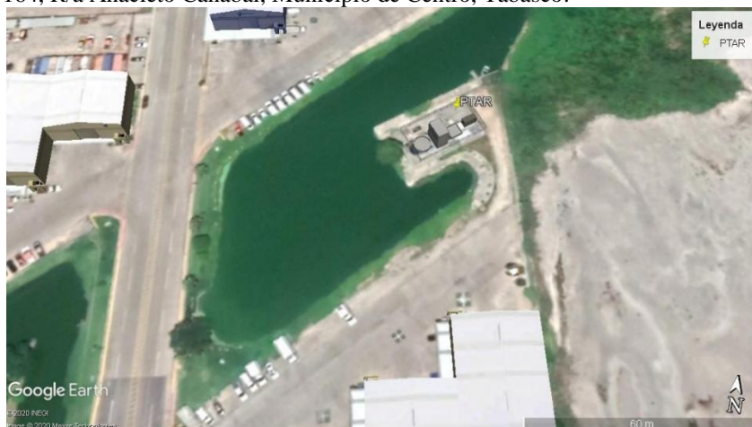
Figura 1 Vista aérea de Planta de Tratamiento de Aguas Residuales del PLIT. 15 Q 501192.00 m E 1989230.00 m N elevación 6 m. Fuente: Google Earth Pro. Imagen 2020 INEGI.
