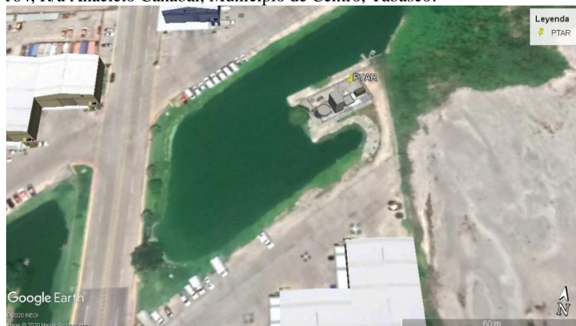
Figura 1 Vista aérea de Planta de Tratamiento de Aguas Residuales del PLIT. 15 Q 501192.00 m E 1989230.00 m N elevación 6 m. Fuente: Google Earth Pro. Imagen 2020 INEG.
