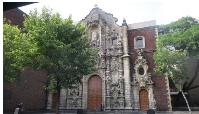
Figura 5. Fachada Principal del Oratorio de San Felipe Neri “el Nuevo”, actual Biblioteca Miguel Lerdo de Tejada.
