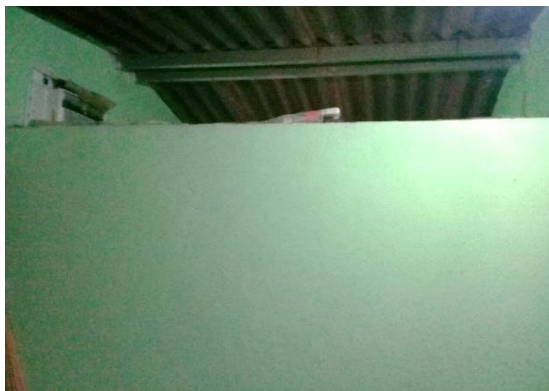
Ilustración 2 Muros bajos interiores. Fuente: propia.
