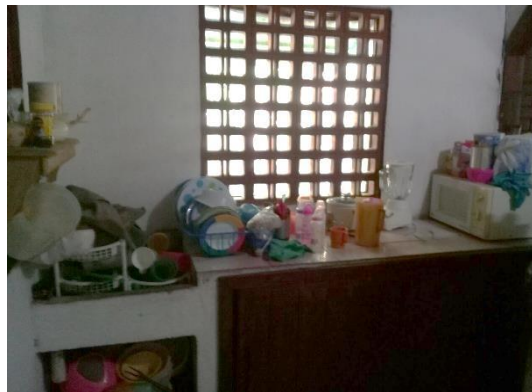
Ilustración 3 Ventana de concreto sin cristal. Fuente: propia.
