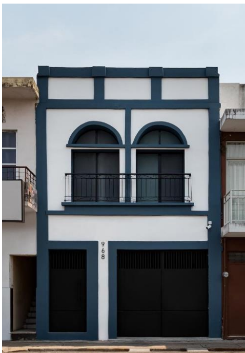
Figura 1. Ejemplo regeneración de fachada, Casa Cielo, Villahermosa Tabasco, por Andammio.
